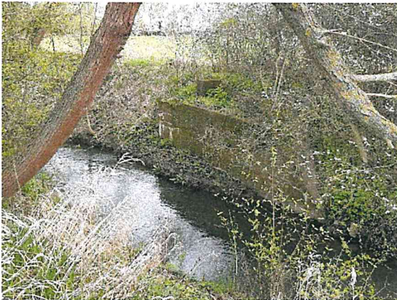
Abbildung 12: alte Brückenwiderlager ehem. Bahntrasse
