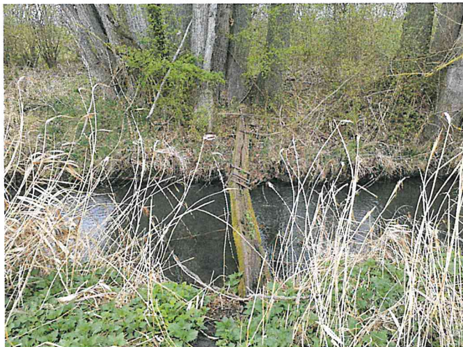
Abbildung 22: instabiler Holzsteg
