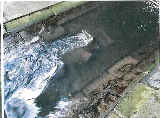
Abbildung 18: ausgebrochene Sohlsteine
